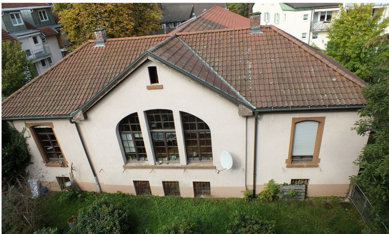
Der zum Abbruch vorgesehene „Bühnensaal“ des Gasthauses. Dahinter das Dach des Zwischenbaus, der den Saal mit dem Hauptgebäude verbindet.
